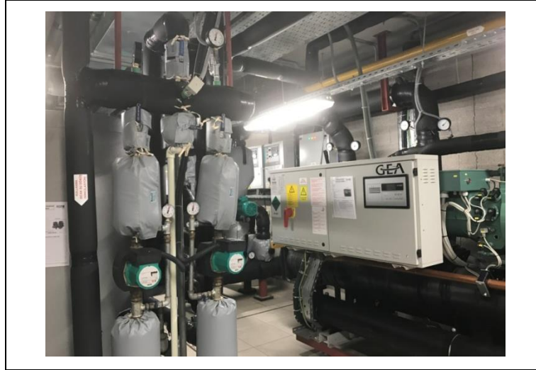
Şekil 68. Gazlı Soğutma Sistemi
