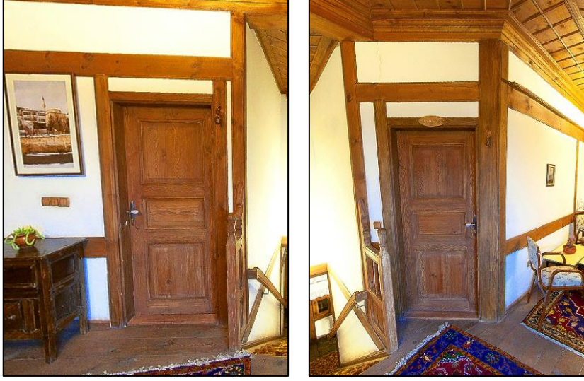
Şekil.124. Uygulanan Kapı Fotoğrafları
