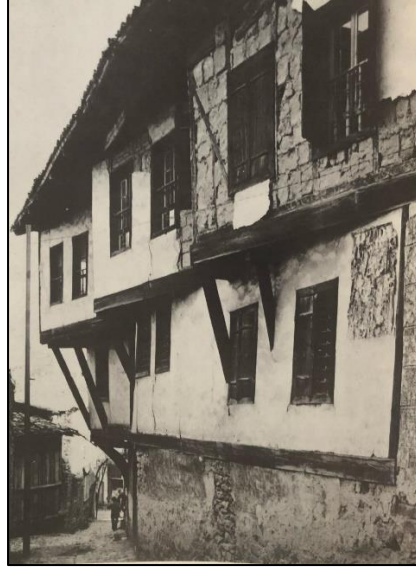
Şekil.38. Kerpicin Kılıcına Örülmesi (Günay, 1989)
