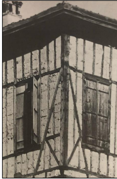
Şekil.39. Ahşap Çatkılar ve Harçla Örülmesi (Günay, 1989)
