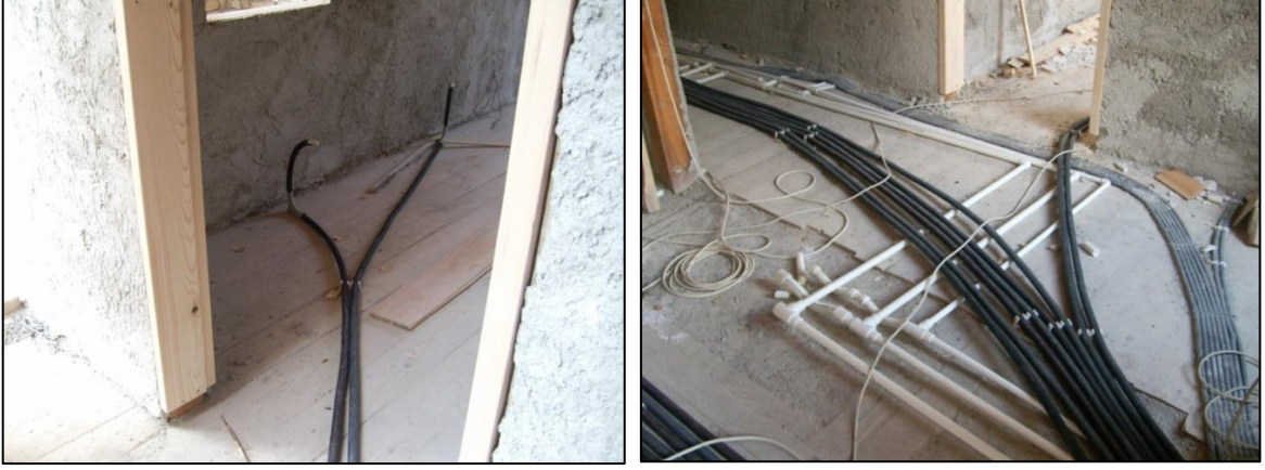
Şekil.114. İnşaat Aşamasından Fotoğraflar
