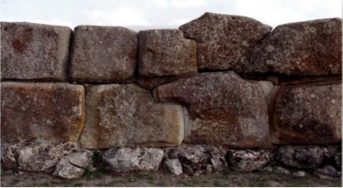
Şekil 70. Alacahöyük duvar örneği.
