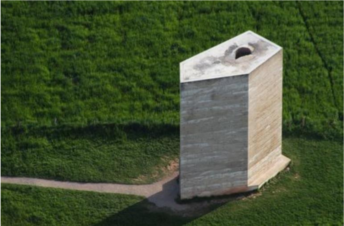
Şekil 4.20. Bruder Klause Şapeli Dış Cephe
