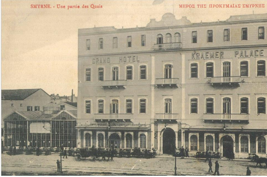
Şekil 4.41. Kraemer Palace, Dört Katlı İken [61]
