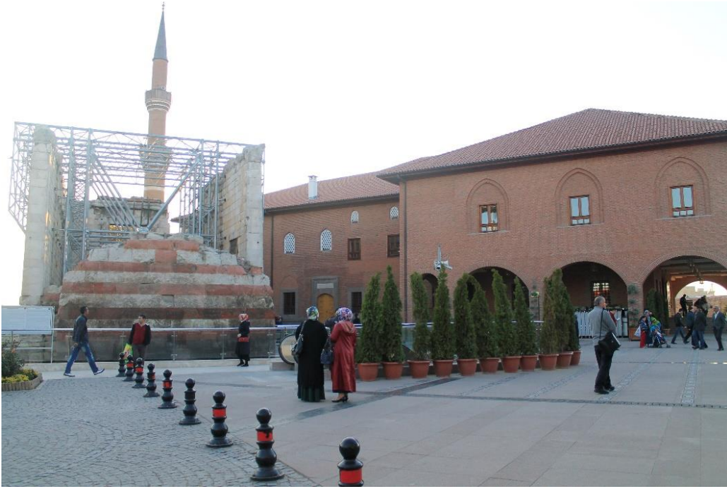
Şekil 3. Hacı Bayram Camii ve Augustus Tapınağı genel görünüm. Fotoğraf: Arzu Beril Kırcı, 2014.
