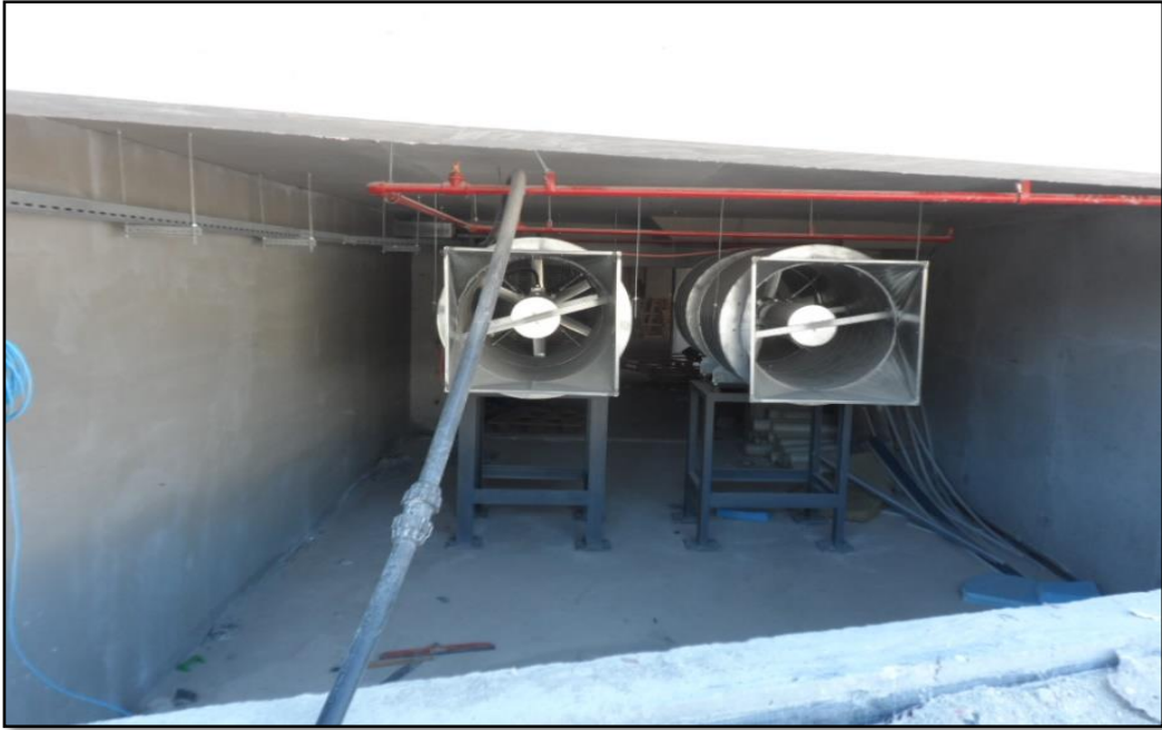
Şekil 10. İnşaat Sırasında Egzoz ve Takviye Hava Tedarik Sistemleri (Araştırmacı, 2018)
