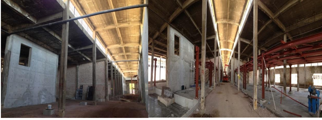
Şekil 59: Agü Sümerbank Ambar Binası Yenileme Çalışma Şantiye Görselfi-2
