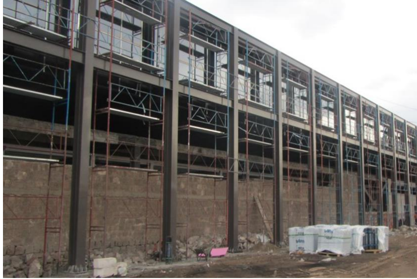
Şekil 61: Ağü Sümerbank Ambar Binası Yenileme Çalışma Şantiye Görseli Cephe Yapım aşaması
