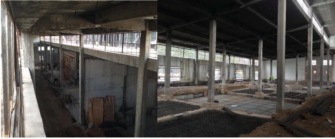
Şekil 60: Agü Sümerbank Ambar Binası Yenileme Çalışma Şantiye Görselfi-3
