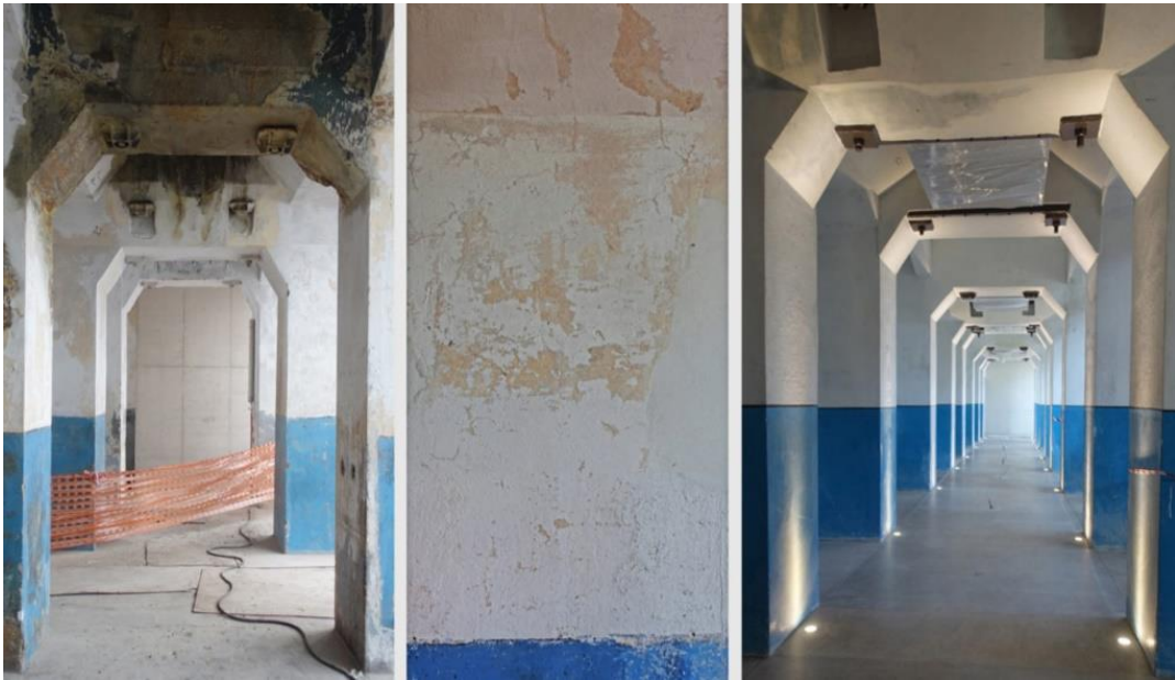
Şekil 82: Elektrik ve Buhar Santrali Duvar eski yeni uygulama görsel
