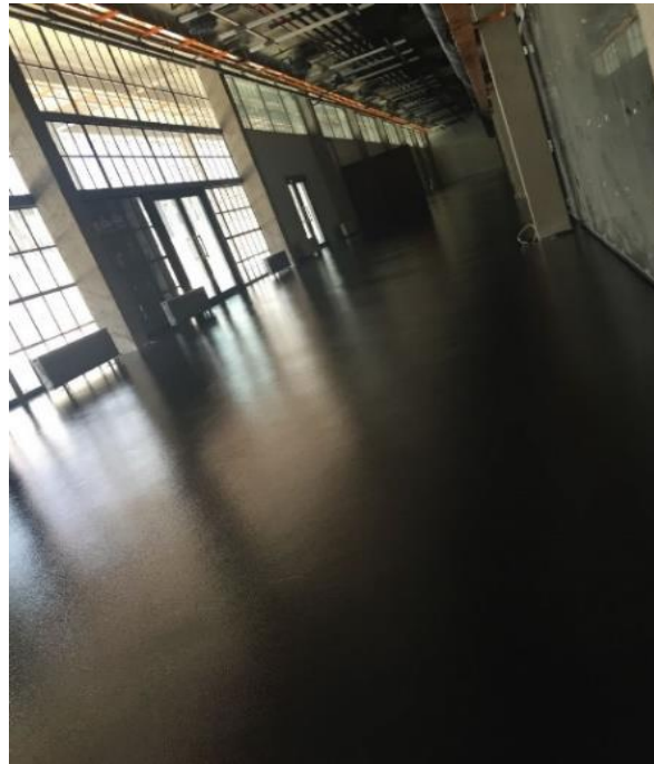
Şekil 80: Agü ana ambar binasının zemin yenilenmesi
