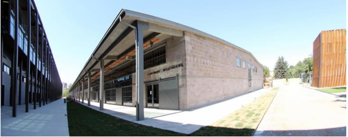
Şekil 65:İtfaiye bina yapısı dış cephe görünümü
