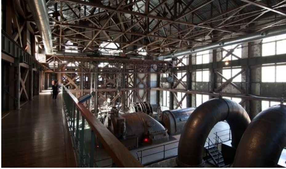
Şekil 39:1 numaralı makine dairesi, müdahale sonrası çelik konstrüksiyon
