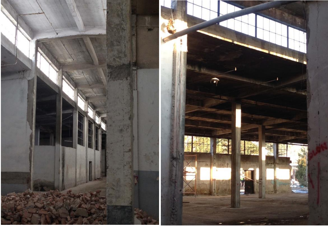
Şekil 57:Agü Sümerbank Ambar Binası Yenileme Çalışma Şantiye Görself
