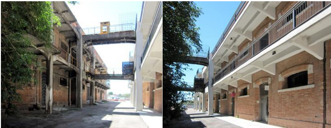
Şekil 3-4 : Derslik olarak yeniden işlevlendirilen antrepo ile doğusundaki işlevlendirilmeden sergilenen antrepo
