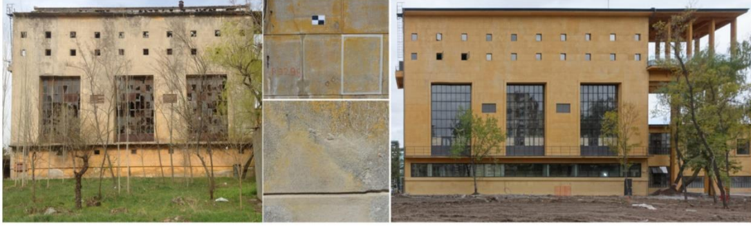
Şekil 66: Elektrik ve buhar santrali eski ve yenilenmiş görsel halleri
