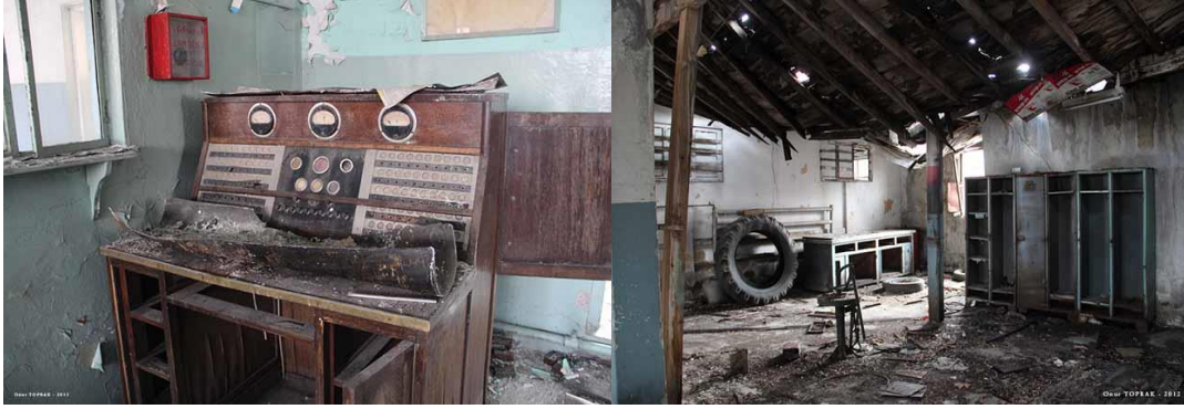
Şekil 54:Kayseri Bez Fabrikası Eski hali görselleri-3
