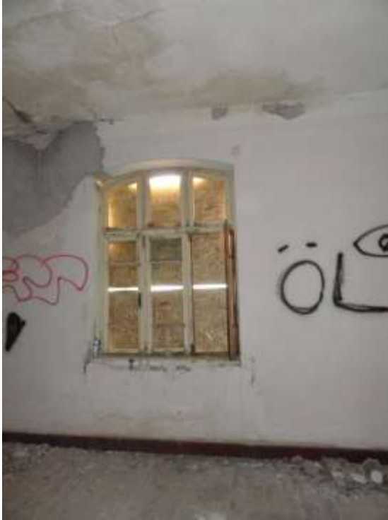
Şekil 5.9. Yonga levhalar ile kapatılan pencerenin içeriden görünümü (05.05.2021)
