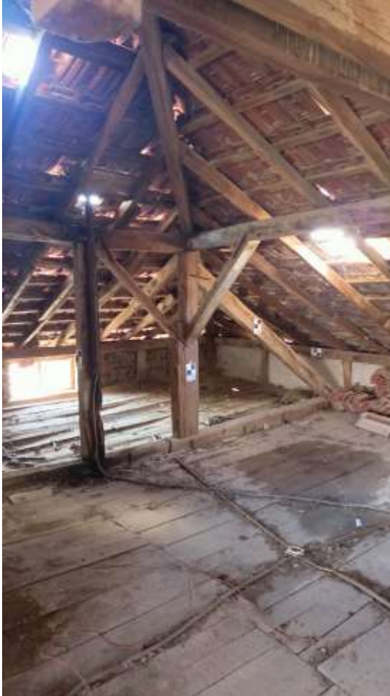
Şekil 5.1. Çatıdaki çökmeler
