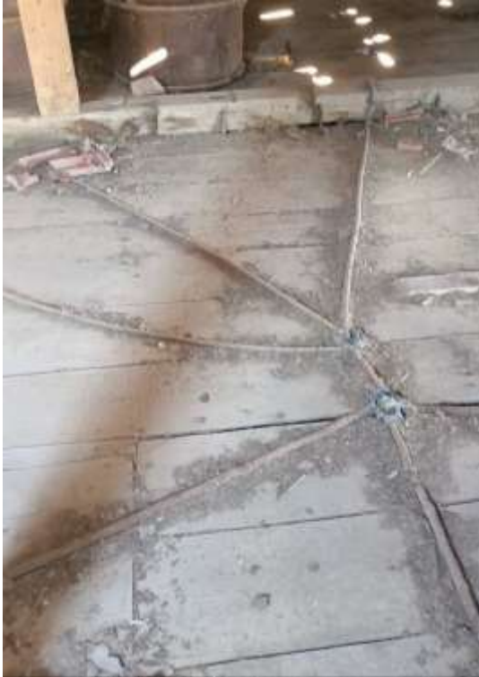
Şekil 4.5. Çatı katının zemininde bulunan elektrik tesisat kabloları
