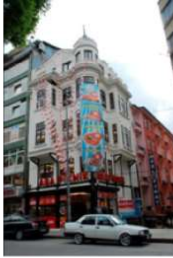
Şekil 4.14. Dairesel forma sahip olma ve kubbesi bulunması ile Mehmet Ağa Konağıyla benzerlik bulunan Ulus / Ankara'da yapı örneği - 2 [47]
