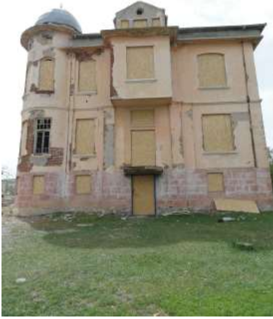
Şekil 5.7. Doğu cephesinde yonga levhalar ile kapatılan açıklıklar (05.05.2021)
