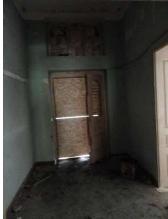
Şekil 5.10. Yonga levhalar ile kapatılan kapının içeriden görünümü (05.05.2021)
