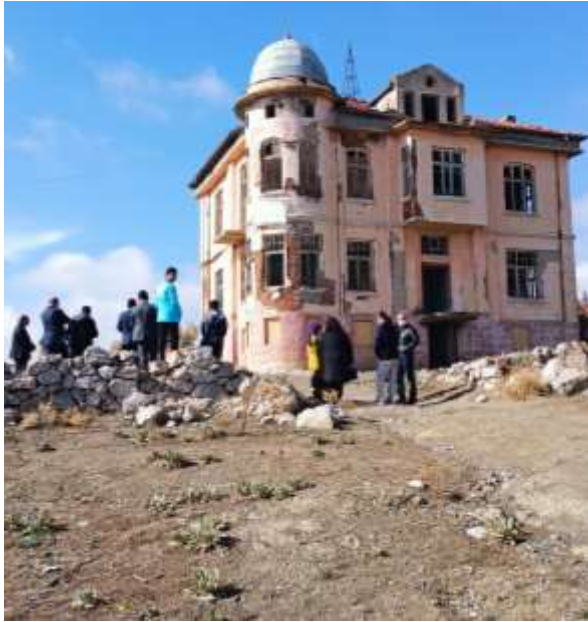
Şekil 6.7. Mehmet Ağa Konağı etrafında görüşme yapan yetkililer
