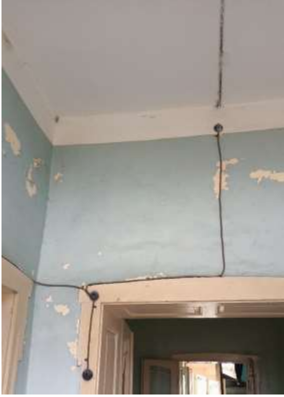
Şekil 4.6. Elektrik tesisat kablolarının yapı içerisinde dolaşımı
